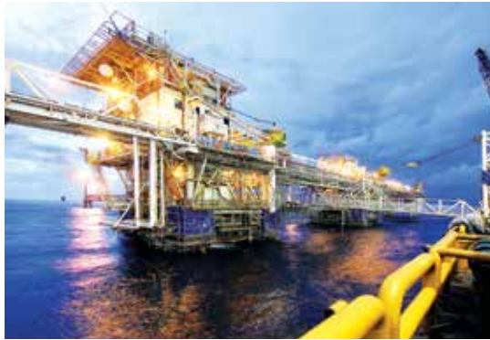
Lima flow station, Blok ONWJ, lepas pantai Jawa Barat bagian Utara.
