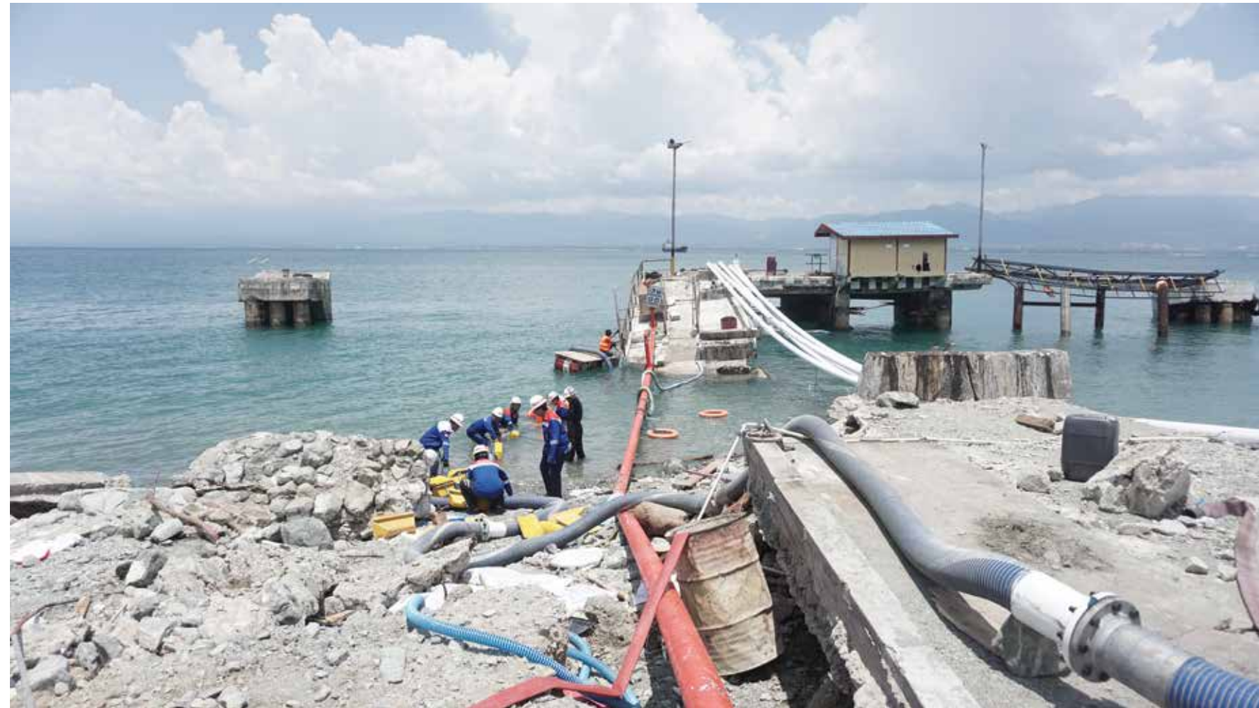
▲ Tim marine MOR VII dan TBBM Donggala, sedang memperbaiki kondisi jetty TBBM Donggala, guna mempersiapkan proses pemindahan bahan bakar dari MT Karmila. Foto : Andrian Adikurnia/Energia News Room
