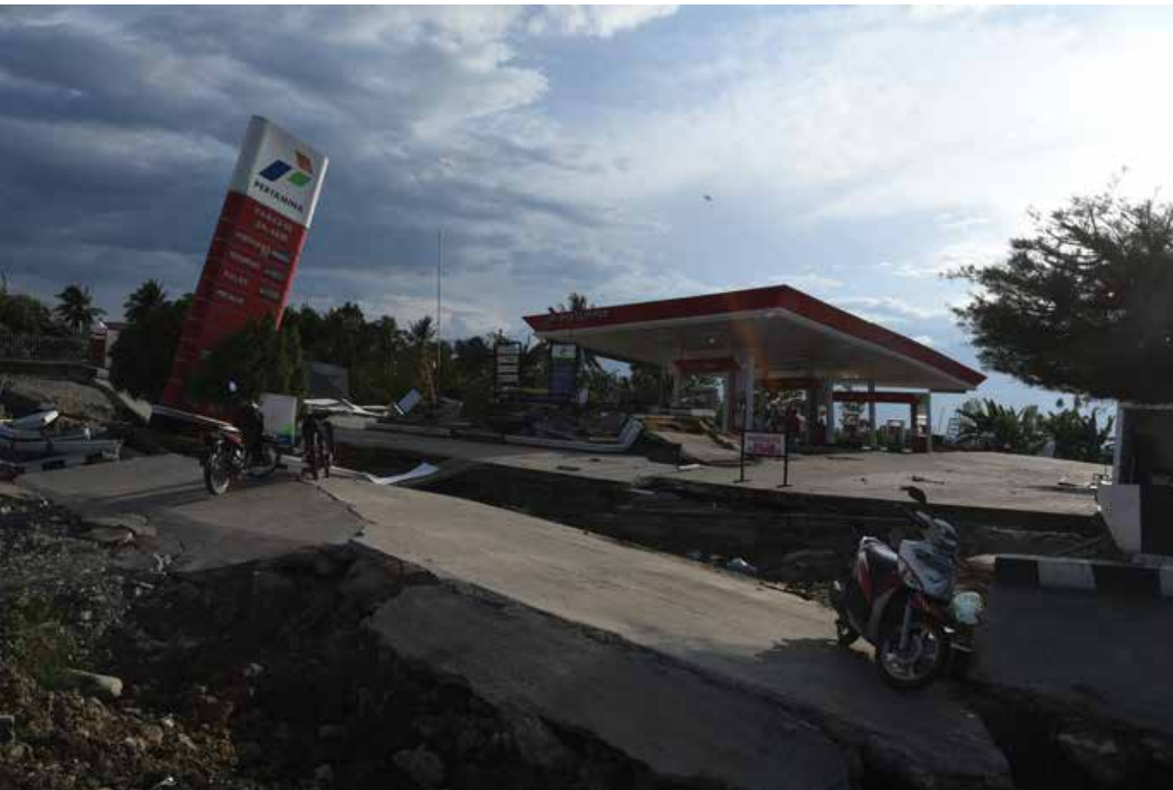
▲ Kondisi SPBU Pertamina 74.943.18 di Kecamatan Sigi setelah diguncang gempa 7,4 SR.
