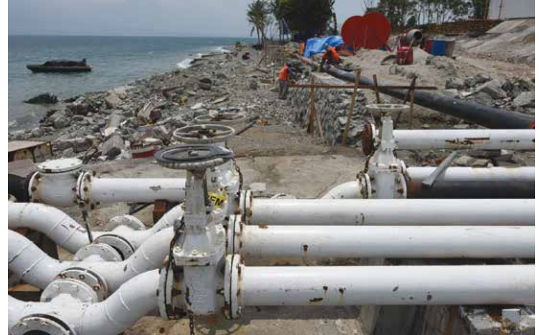
▲ Sejumlah pekerja memperbaiki fasilitas di TBBM Donggala, Palu, Sulawesi Tengah.
