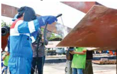
Keel Laying kapal mooring boat pertama di Dockyard Sorong ditandai dengan pengelasan plate .
