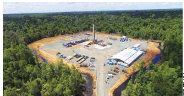
Situasi lokasi pengeboran sumur SBK-A, Struktur Sembakung – Kaltara.
