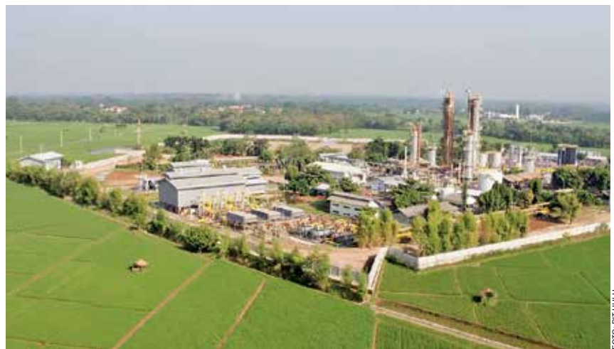
Stasiun Pengumpul (SP) Subang, Subang Field.
