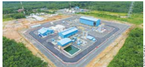
Stasiun Pengumpul Gas (SPG), Paku Gajah, Prabumulih Field, Sumatera Selatan.
