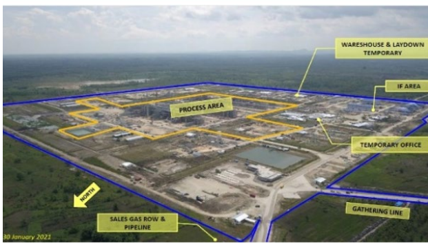
Progres Proyek Pengembangan Lapangan gas Jambaran Tiung Biru
