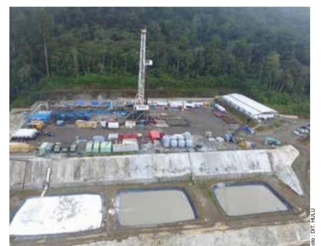
Lokasi Pengeboran Sumur HLS-E/1, Cluster E, Hululais menggunakan Rig PDSI 12.3/N110-M.
