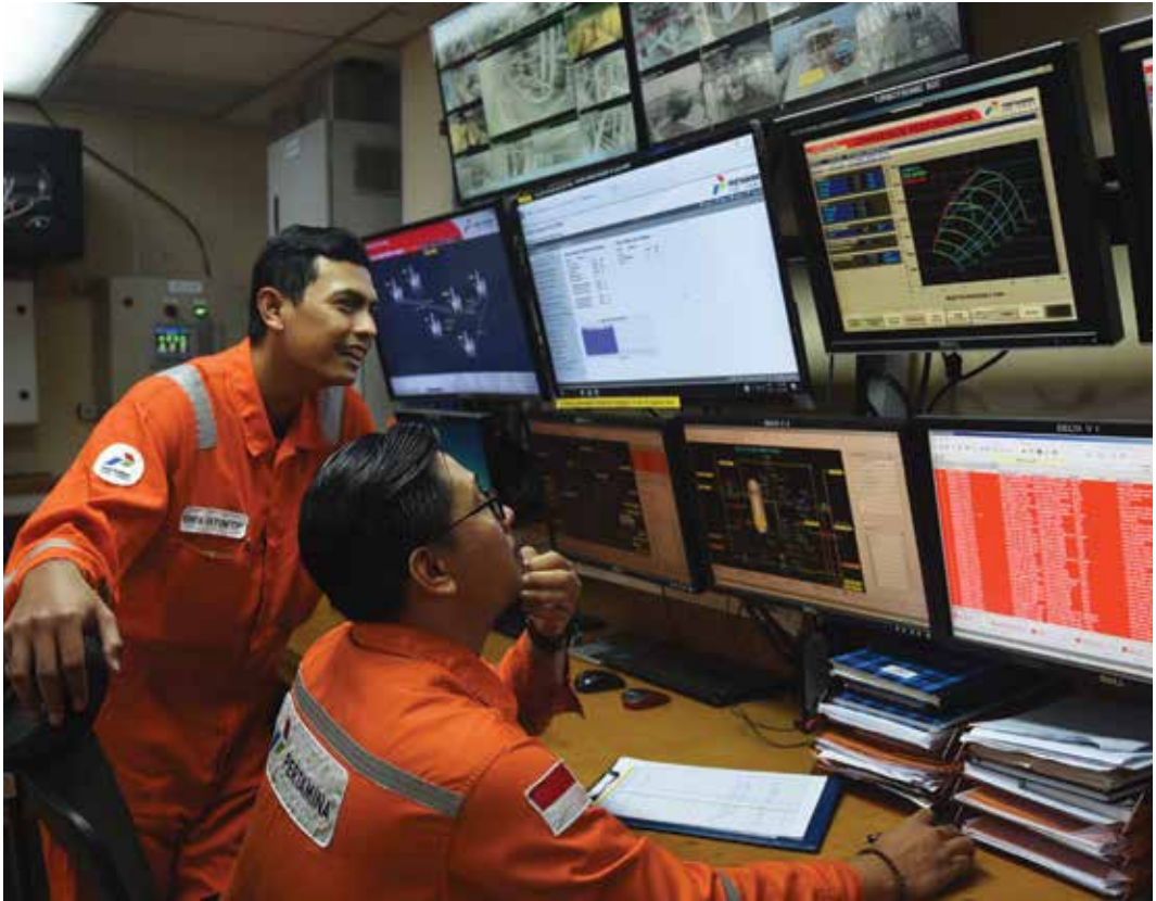
Dua pekerja melakukan pengecekan di Control Room.
