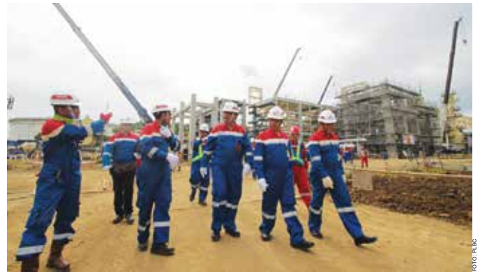
Direktur Megaprojek Pengolahan dan Petrokimia Ardhy N. Mokobombang Didampingi SVP Project Execution Ignatius Tallulembang dan SVP Project Development Achmad Fathoni Mahmud, Ardhy memantau langsung aktivitas kerja di arena Axens dan FOC-I saat management walkthrough (MWT) ke area kerja PLBC, pada (26/1/2018).
