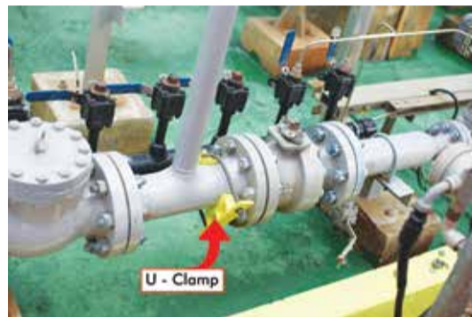
(Atas) U-Clamp yang dipasang pada Flow Line "LD" dan (Bawah) U-Clamp yang dipasang pada Outlet Slug Chatcher
