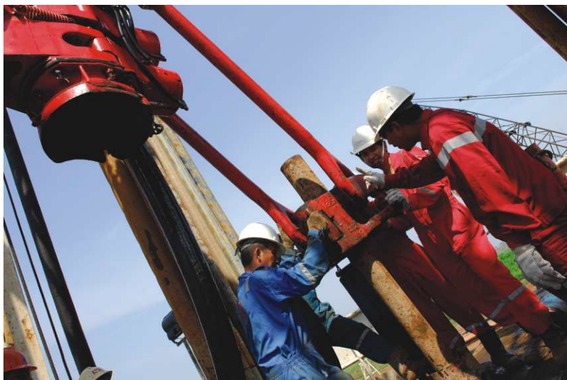
Drilling Lapangan Pondok Tengah Bekasi
