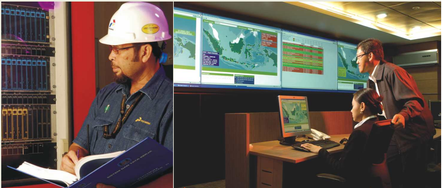
Control Room di Jakarta
